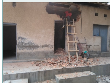
Travaux de réhabilitation de la maison du médecin
